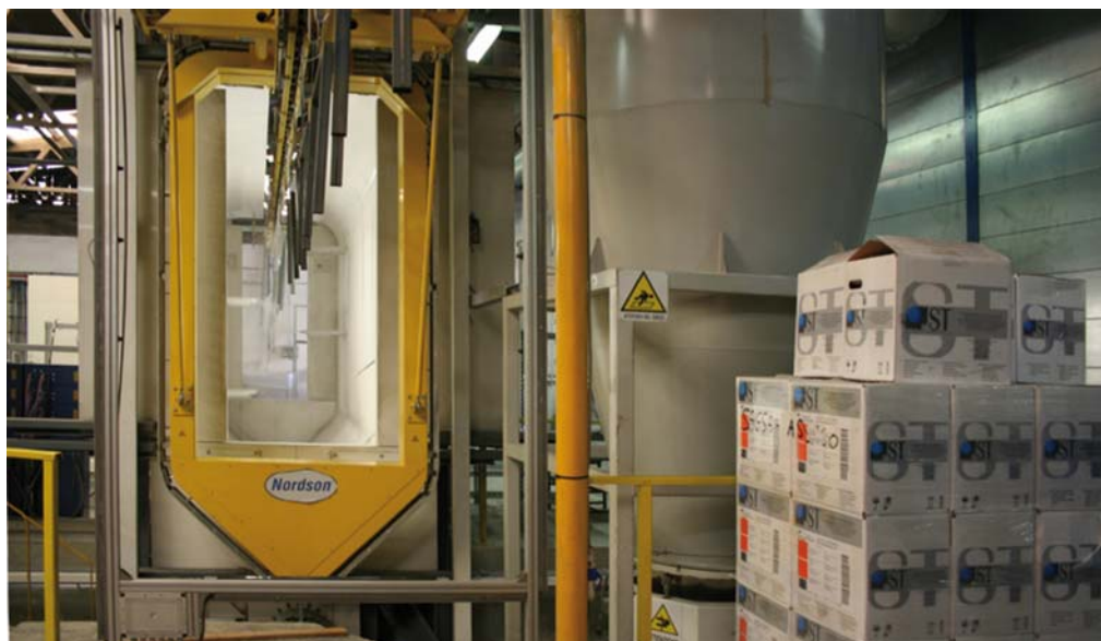
11 – La cabina di erogazione polveri, con pulizia completamente automatica, via trolley, per il cambio colore. The powder delivery booth, with fully automatic cleaning, via trolleys, for the colour change.
